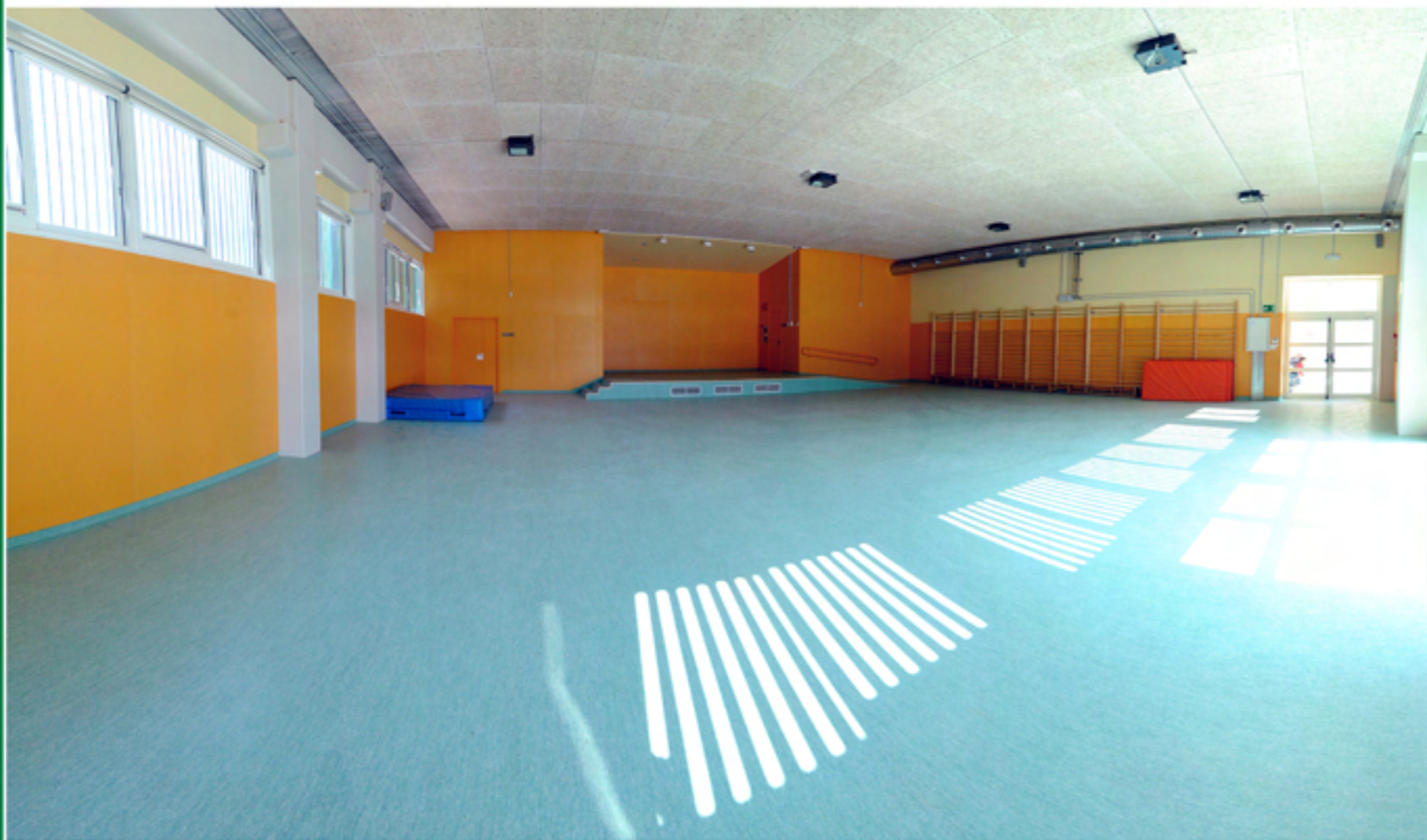
CEIP Can Coll (Torrelles) obra finalitzada
