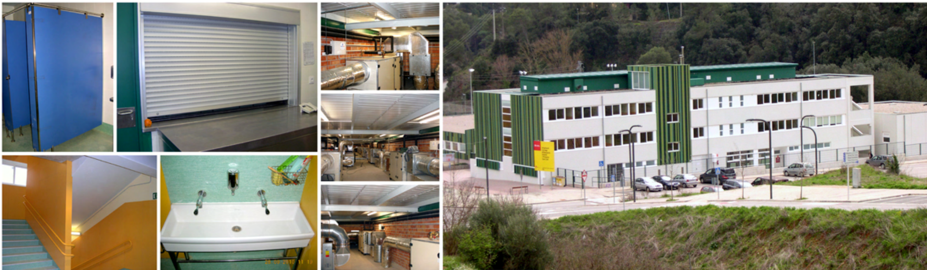
CEIP Can Coll (Torrelles) obra finalitzada
