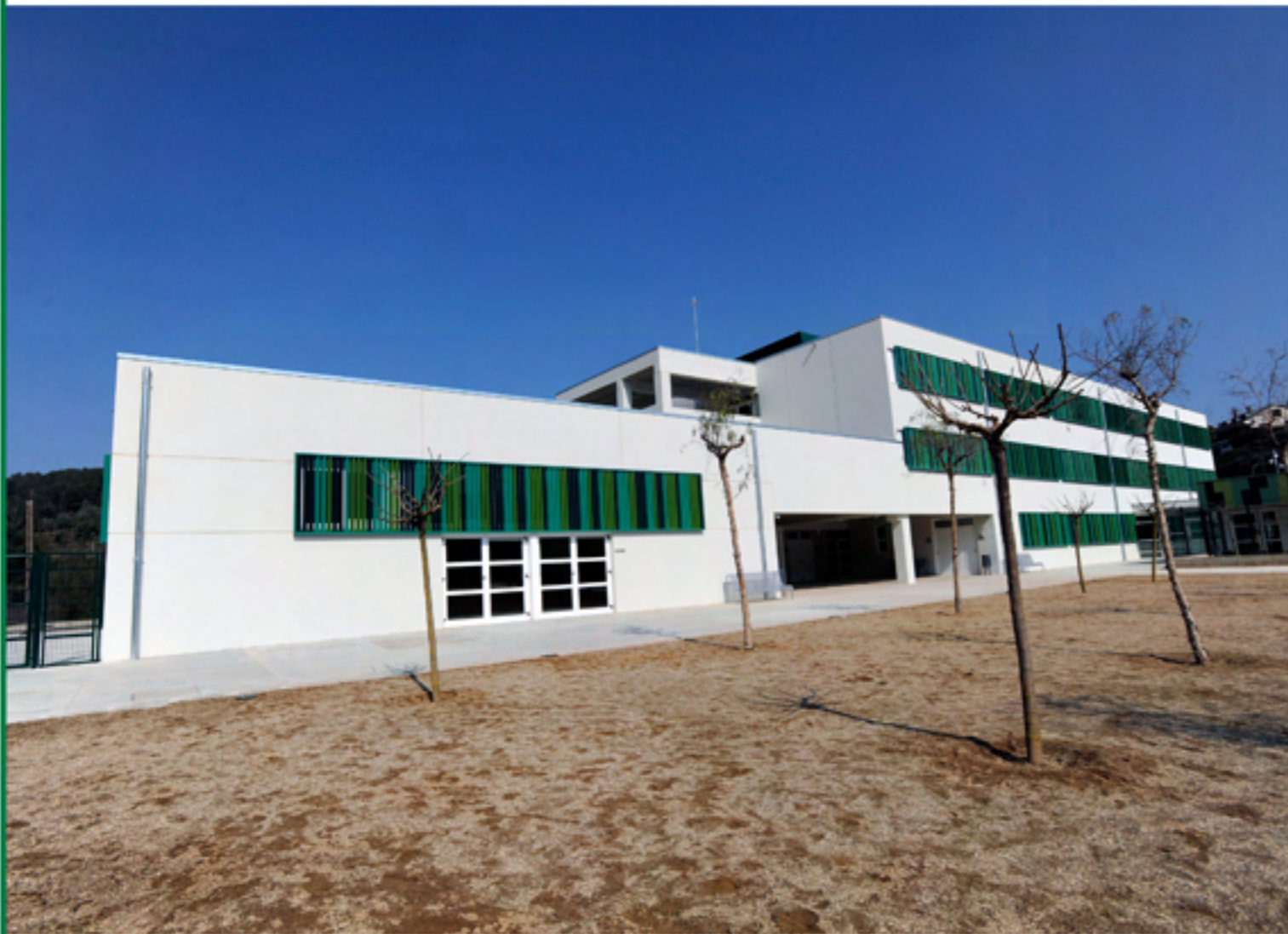
CEIP Can Coll (Torrelles) obra finalitzada
