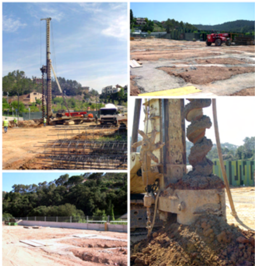
CEIP Can Coll (Torrelles) obra en execució
